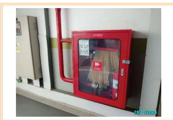
รูปที่ 2.5.9-6 ตู้เก็บสายฉีดน้ำดับเพลิง
