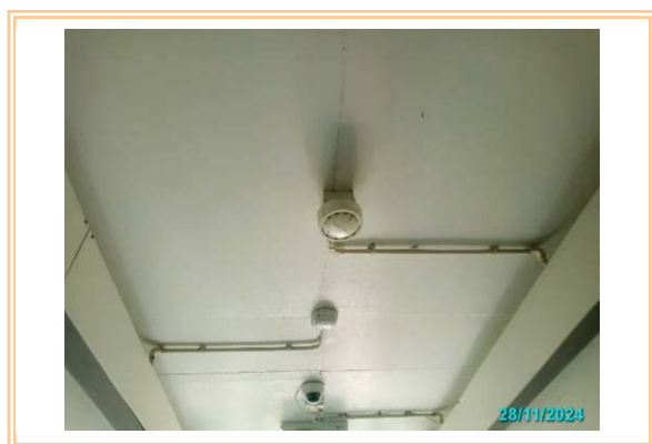
รูปที่ 2.5.9-3 อุปกรณ์ตรวจจับควัน
