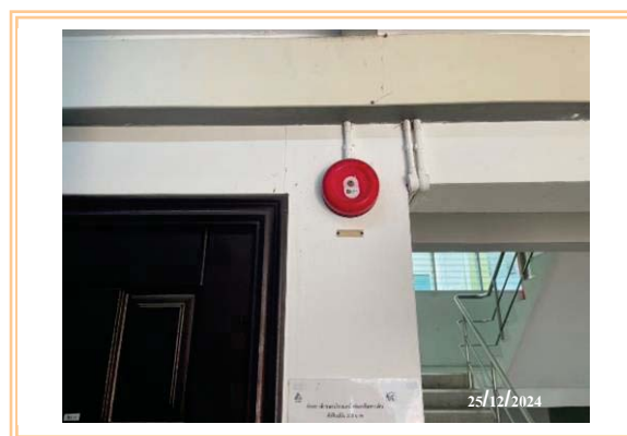
รูปที่ 2.5.9-2 อุปกรณ์ส่งสัญญาณแบบกริ่ง
