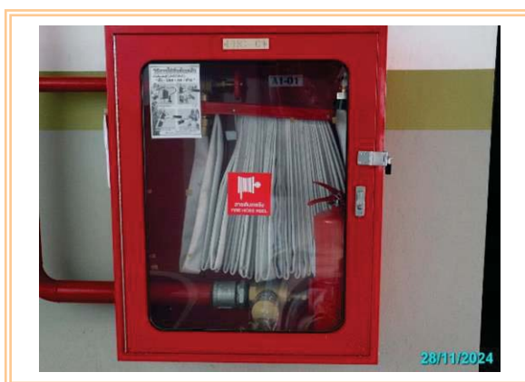
รูปที่ 2.5.2-2 ตู้เก็บสายฉีดน้ำดับเพลิง
